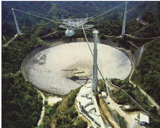
Рис. 41. Радиотелескоп Аресибо (Пуэрто-Рико). Приёмное устройство является подвижным и подвешено на тросах к трём башням. Наведение телескопа на заданную точку небесной сферы осуществляется путём перемещения приёмного устройства
