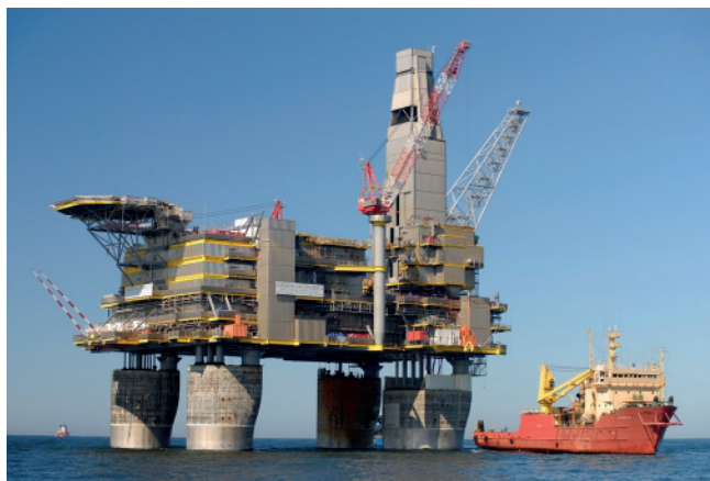
Рис. 15. Буровая и добывающая платформа. Установлена в Охотском море (Сахалин) в 14 км от побережья на глубине 48 м. Предназначена для добычи газа для завода по производству СПГ.
