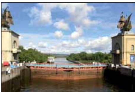
Рис. 198. Один из самых красивых шлюзов канала им. Москвы — шлюз № 3, который поднимает суда на 8 метров
