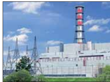
Рис. 133. Курская атомная электростанция
