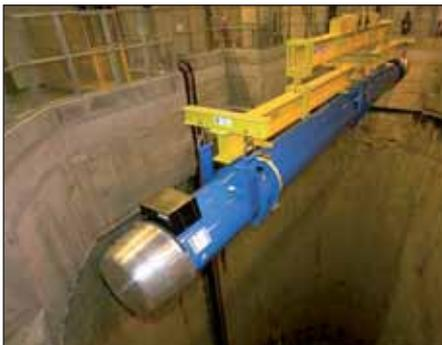
Рис. 180. Пятнадцатиметровый поворотный магнит спускают в шахту для установки на Большом адронном коллайдере
